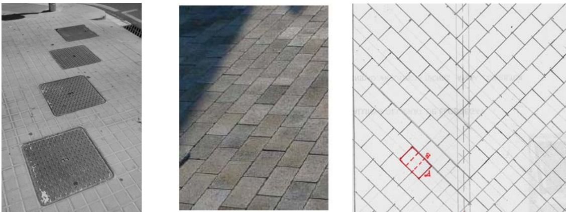
Figura 4.- Barcelona. Relación entre tapas y las dimensiones del panot ( 20x20). Pavimento tipo Zehn de Breinco. La colocación en espina de pez, Necesidad de ranuras de encaste en la cara de mayor longitud adaptada al solape de 1/3 y 2/3.
